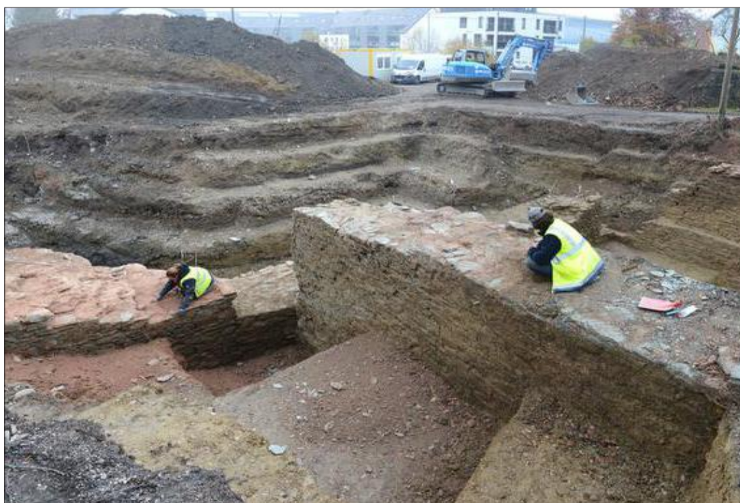
Vor drei Jahren waren die Mauerreste der früheren St.Vith Burg größtenteils freigelegt worden. Seither hat sich auf dem Areal nichts mehr getan.
